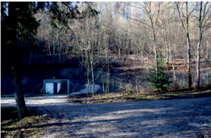
Die tiefbautechnischen Maßnahmen sind abgeschlossen
