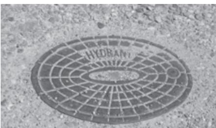
auffällig. Die Hydranten werden mit einer ebenerdigen Straßenkappe verschlossen und sind zusätzlich mit einem Schild in der Nähe gekennzeichnet. Auf dem Schild ist die genaue Lage des Hydranten vermerkt, was das Auffinden der Unterflurhydranten erleichtert. Das Wasser wird mit Hilfe eines Standrohrs entnommen, das auf den Löschfahrzeugen mitgeführt wird.
