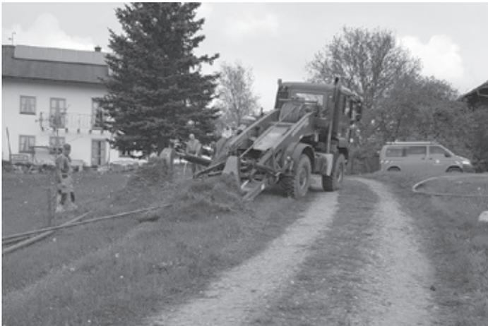
*Auf Antrag der Grundbesitzer Oed und Hoswaschen wurden sieben, bisher nicht an die Gemeindewasserversorgung angeschlossenen Anwesen mit einer neuen Wasserleitung erschlossen. Die beauftragte Firma Dimpfleier verlegte im Pflugverfahren ca. drei Kilometer Wasserleitung. Gleichzeitig wurde im Auftrag der NGN das Leerrohr für diese Anwesen mit verlegt.*
