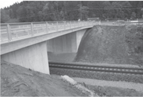
Brückenbauwerk Krücklham mit den gleichen Ausmaßen wie die Planung in Mühlthal
