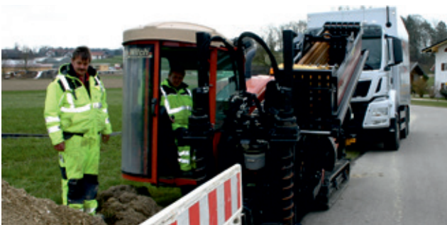
Die Verlegung der Glasfaserkabel geht zügig voran.
