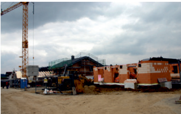
Baustellen an der alten Parkettfabrik
