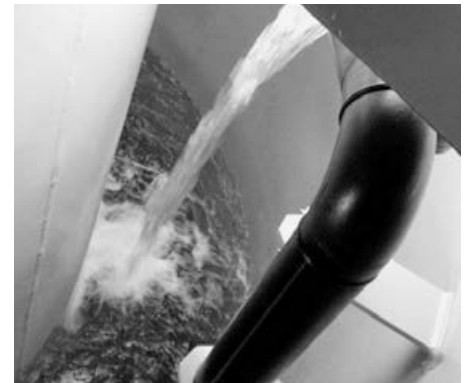
Blick in die Wasserkammer (Wassereinlauf)
