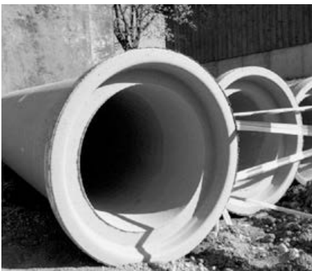
Die neuen Rohre für die Umverlegung
