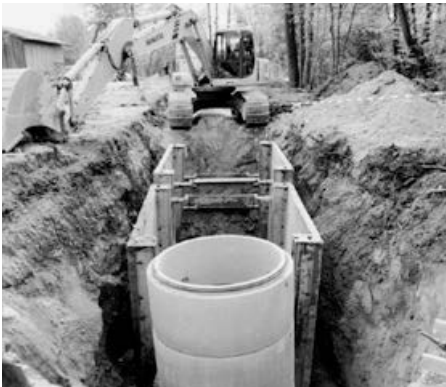
Blick in den 5 m tiefen Graben
