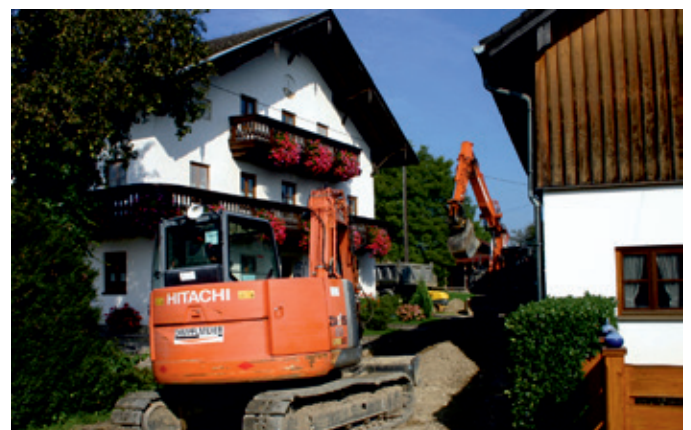
Die Kanalarbeiten in Seeburg sind im vollen Gange
