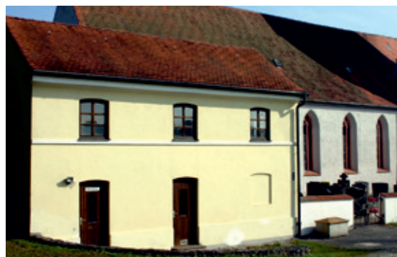
Die öffentlichen Toiletten neben der Kirche in Rieden werden bald saniert
