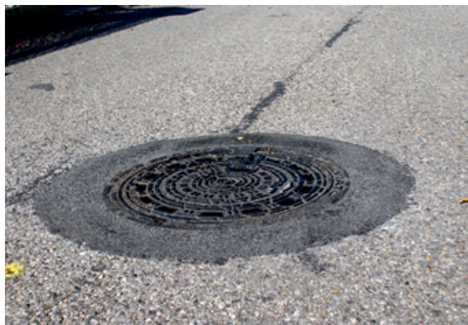
Vierzig neue Kanaldeckel waren aus Sicherheitsgründen für Soyens Straßen notwendig
